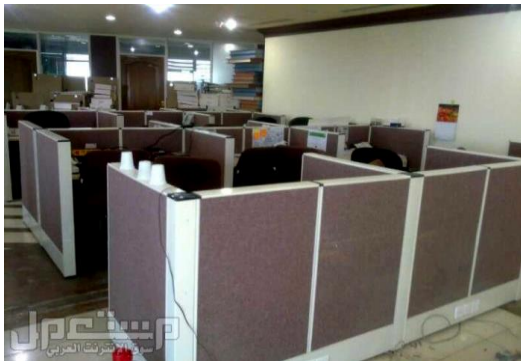
صورة رقم (٤) توضح تركيب مجموعة لقواطع إدارية.
